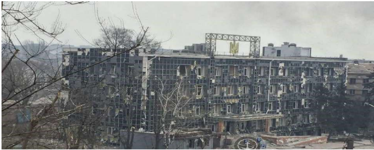
Краснолиманський міський суд Донецької області - будівля суду повністю зруйнована.
